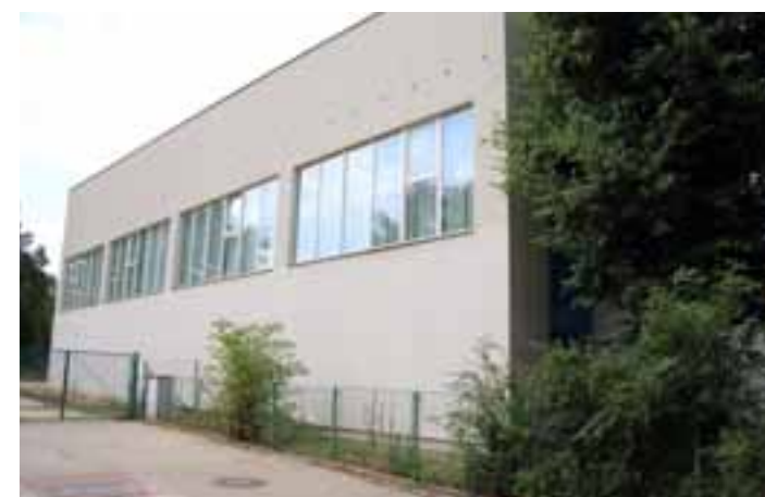
Přístavba nové tělocvičny
