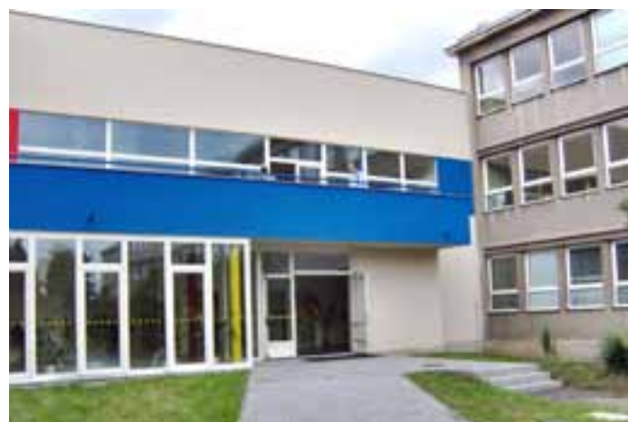
Přístavba nové tělocvičny
