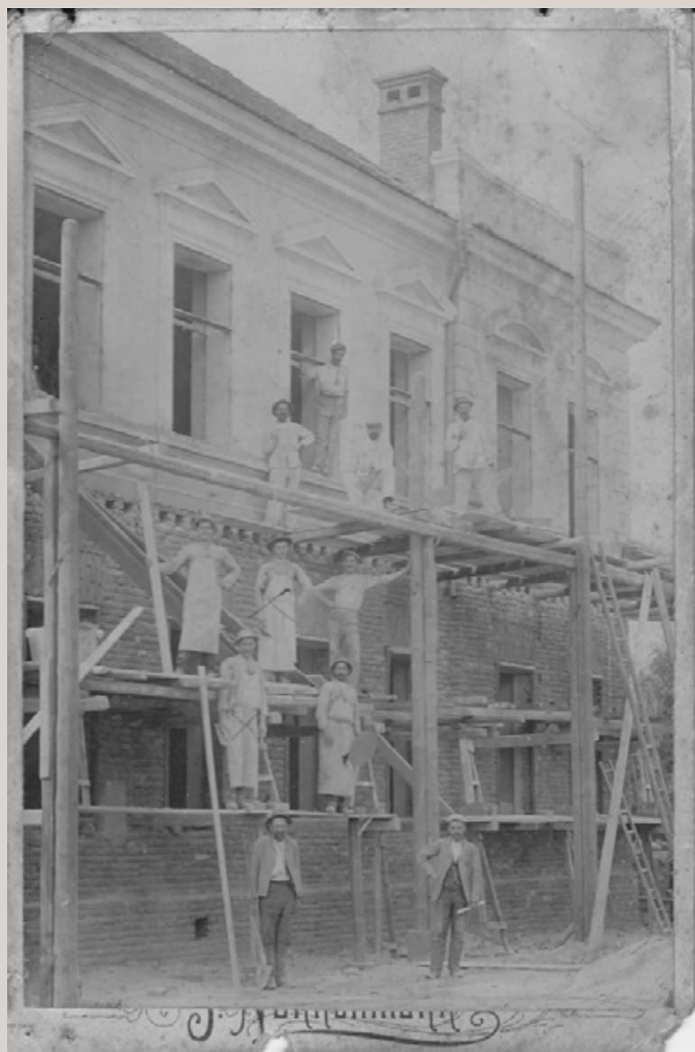
Stavba staré školy
