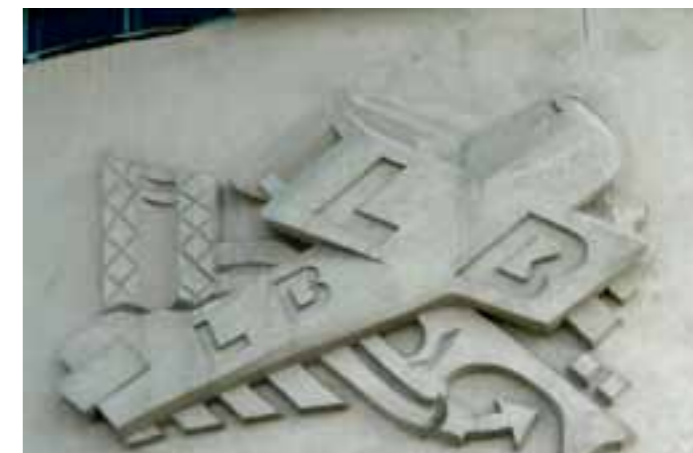
Kubistický reliéf na severní straně vodojemu. Současný stav.
