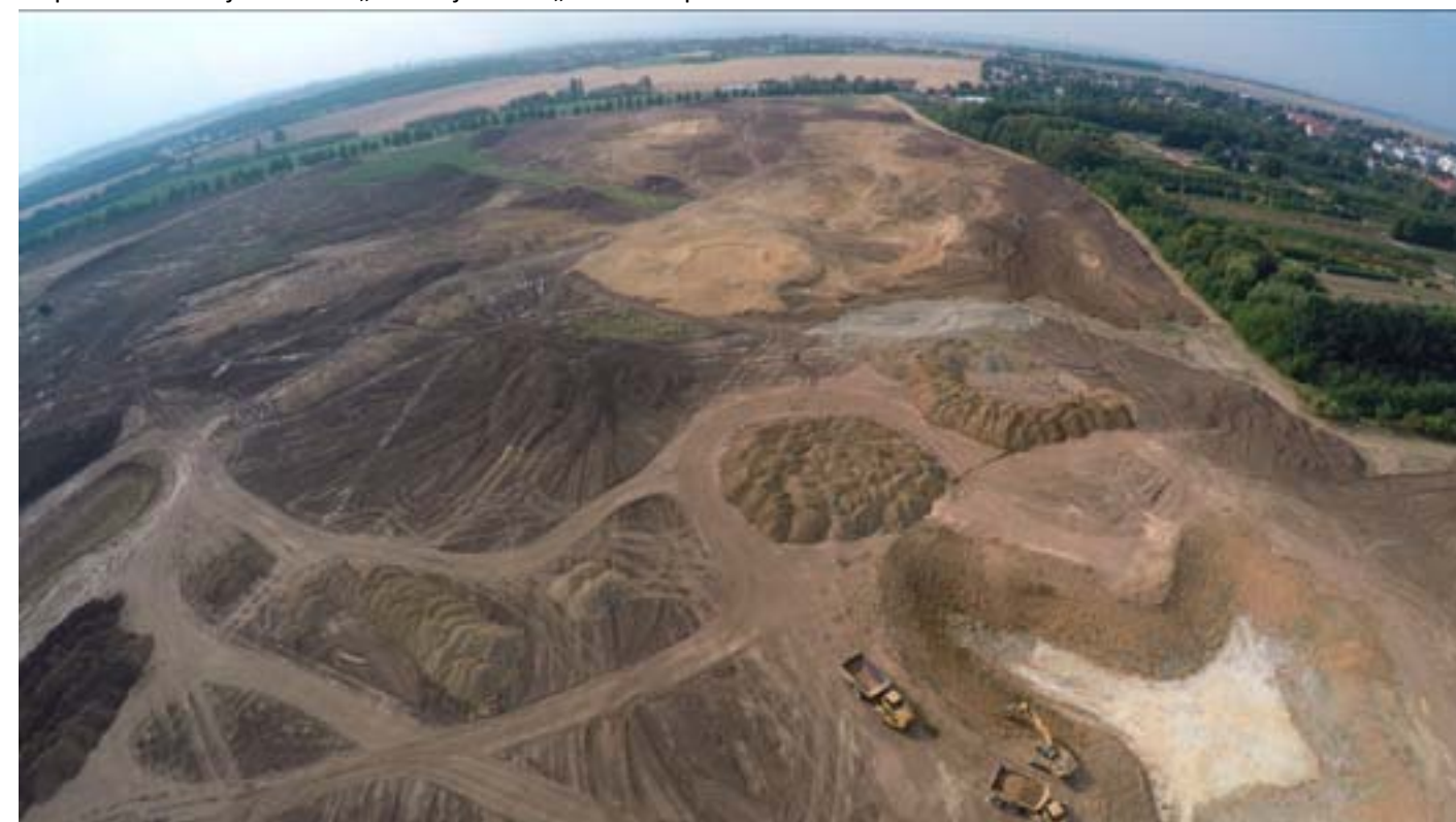
Probíhající výstavba golfového hřiště Golf Vinor (foto: MB, 8/2015)
