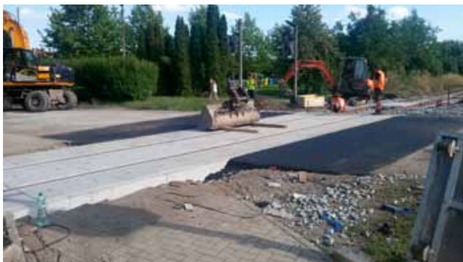
Práce na železničním přejezdu na Mladoboleslavské ulici
