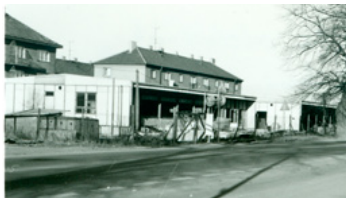
Stavba obchodních pavilonů na Mladoboleslavské ulici, dnes drogerie, rok 1978
