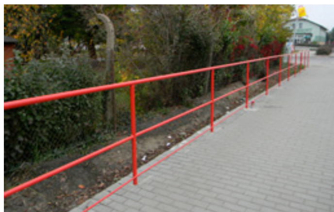
Obr. 3 Společně s výstavbou nového obchodního centra byla vybudována také nová autobusová zastávka „Vinoř“ na Mladoboleslavské ulici. I zde bylo použito poměrně netradiční řešení – chodník na zastávce je neobvykle ukloněn místo do vozovky do přilehlé zeleně. Podél chodníku byl vyhlouben mělký příkop, kde se může voda vsakovat a neodtéká zbytečně do kanalizace.
