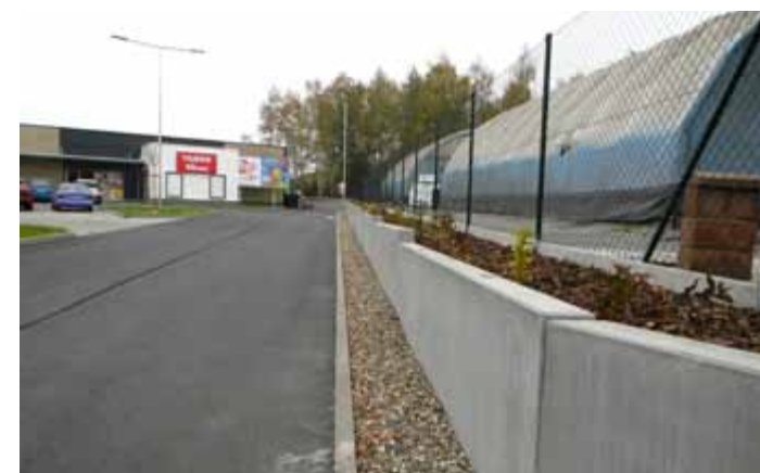
Obr. 1 Investor vsadil na jednoduché opatření, které nezvyšuje cenu díla – obrubníky jsou netradičně zcela zapuštěny, jejich horní hrana je v úrovni komunikace a voda může volně přetékat do okolního terénu (v tomto případě do úzkého pruhu, vyplněného štěrkem), kde se přirozeně vsakuje a neodtéká přímo do kanalizace.
