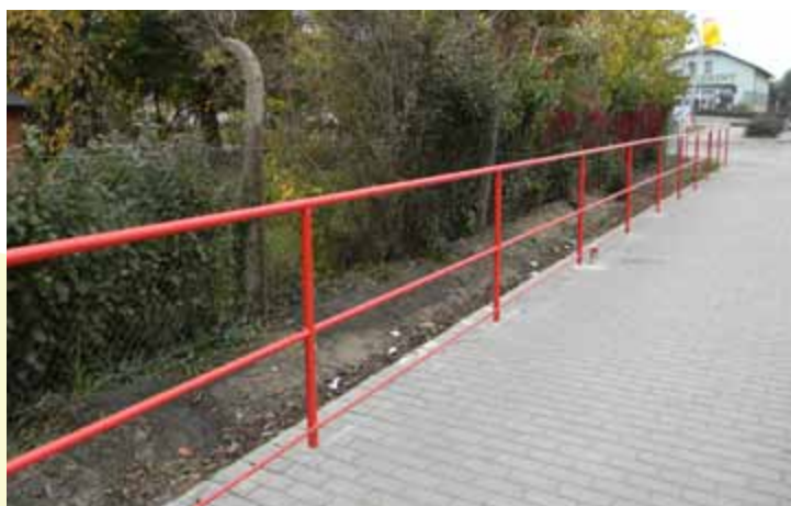
Obr. 3 Společně s výstavbou obchodního centra byla vybudována také nová autobusová zastávka „Vinoř“ v Mladoboleslavské ulici. I zde bylo použito poměrně netradiční řešení – chodník na zastávce je nezvykle ukloněn místo do vozovky do přilehlé zeleně. Podél chodníku byl vyhlouben mělký příkop, kde se může voda vsakovat a neodtéká zbytečně do kanalizace.
