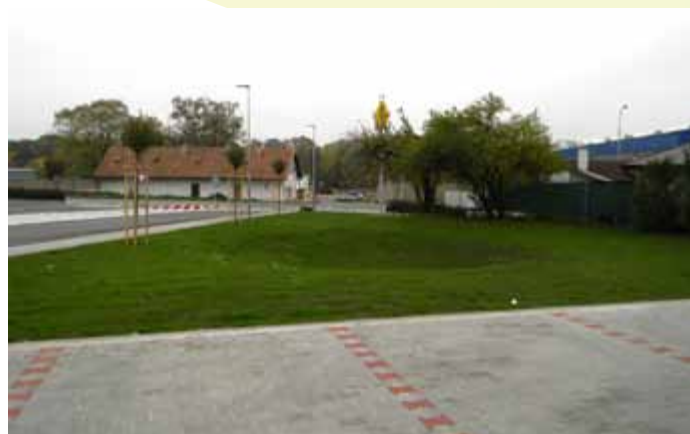
Obr. 2 Zatravněný polder, do kterého je odváděna voda z podzemního vsakovacího objektu při jeho naplnění. I zde investor zcela zapustil obrubníky, díky čemuž může voda volně přetékat do okolní zeleně, kterou není následně nutné tolik zavlažovat.
