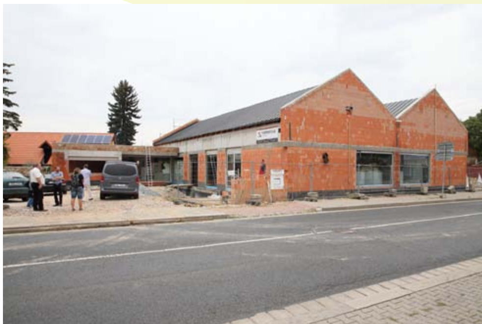
Pivovarskou technologii bylo třeba začít instalovat již začátkem září, aby se pivo stihlo nejen uvařit, ale mělo i dost času na kvašení a zrání.
