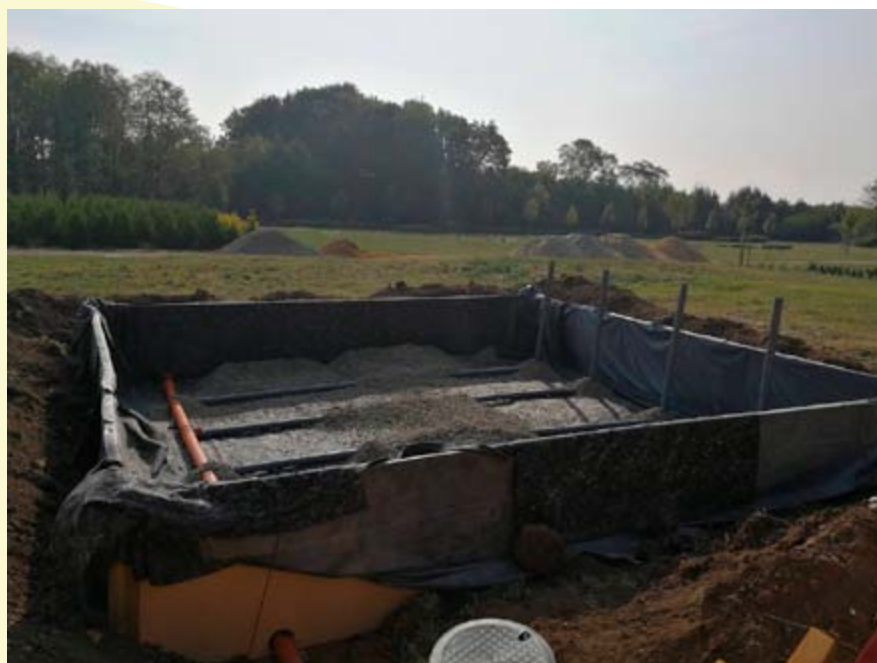
Obr. 2: Stavba KČOV v areálu PRALES.
