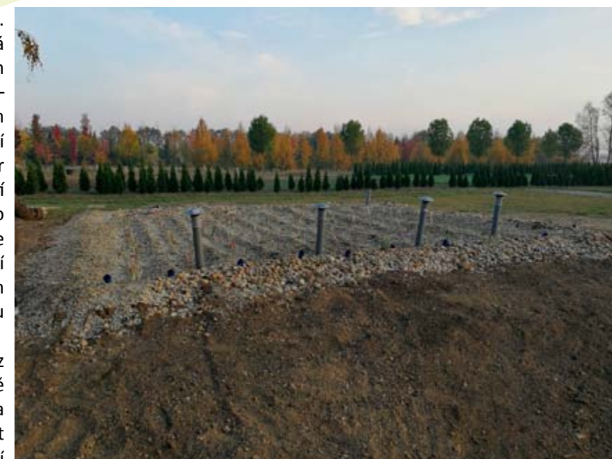
Obr. 3: Výsledná podoba KČOV v areálu PRALES (listopad 2018).
