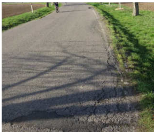
Obr. 42: Zlom na kraji vozovky, příkrý svah příkopu;
