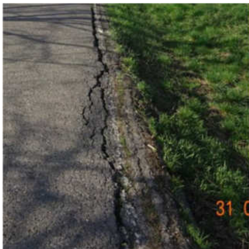
Obr. 41: Podélná trhlina ve vozovce a příkrý sklon příkopu; rhlina v budoucím jízdním pruhu pro cyklisty
