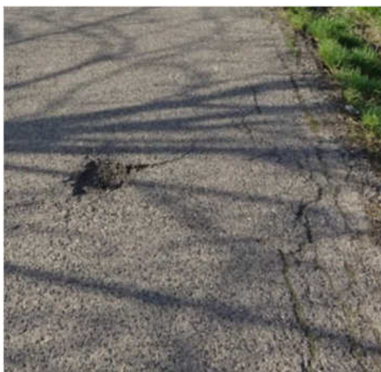
Obr. 39: Výtluk v ploše budoucího jízdního pruhu;
