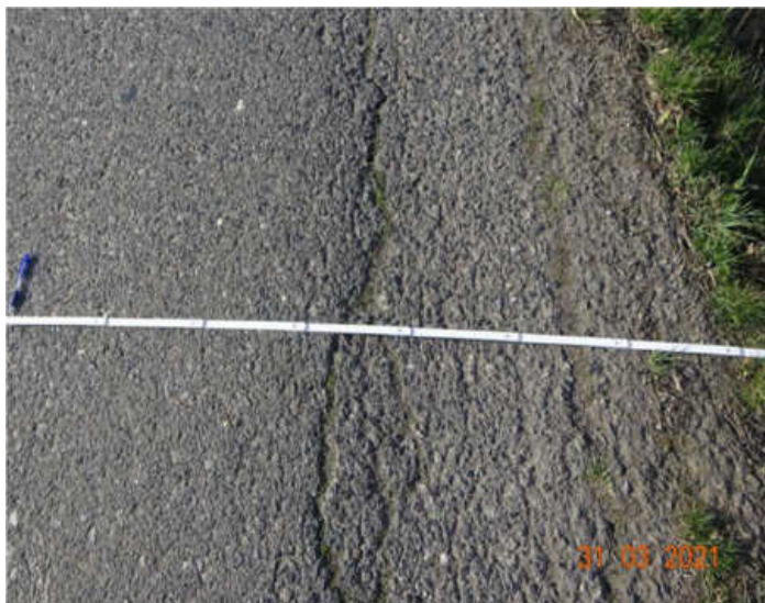
Obr. 20: Stav krytu pro budoucí jízdní pruh v detailu
