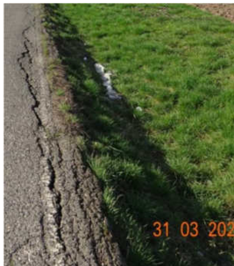
Obr. 38: Podélná prasklina okraje vozovky v ose budoucího pruhu pro cyklisty; Zborcený okraj silnice, příkrý příkop
