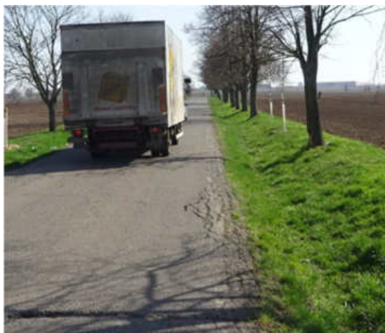
Obr. 3: Dokumentace šířkových poměrů komunikace vůči nákladnímu vozidlu.
