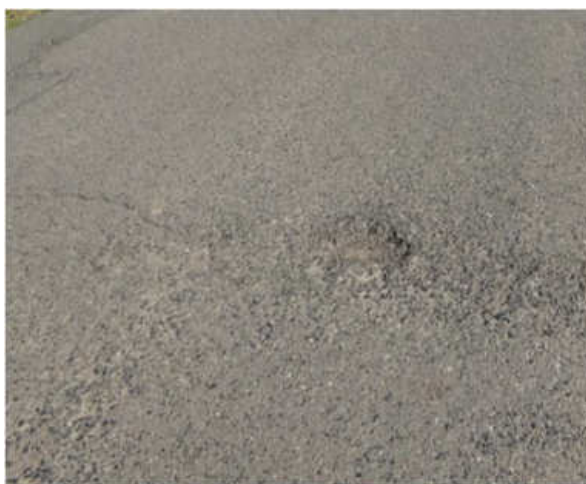
Obr. 47: Výtluk uprostřed jízdního pásu, odlomený okraj vozovky;
