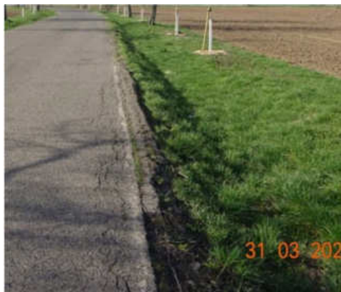
Mozaikový rozpad kraje a příčný výtluk
