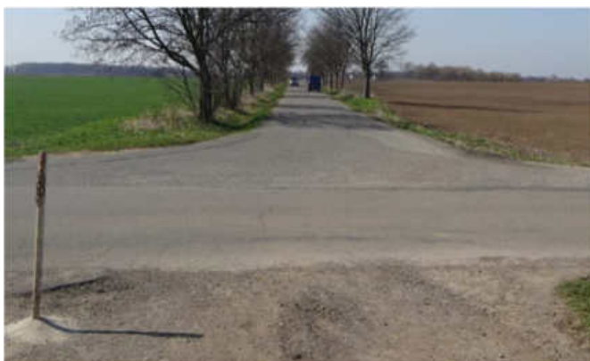
Obr. 24: Doplnění živice ve vnitřních obloucích křižovatky
