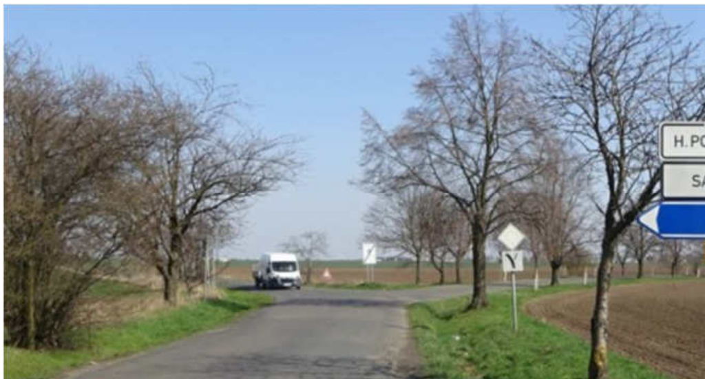
Obr. 10: Celkový pohled na křižovatku ve směru od Víně.
