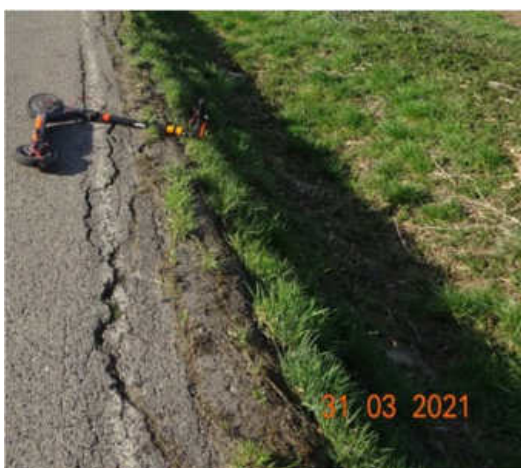
Obr. 43: Odlomený kraj vozovky, příkrý příkop;
