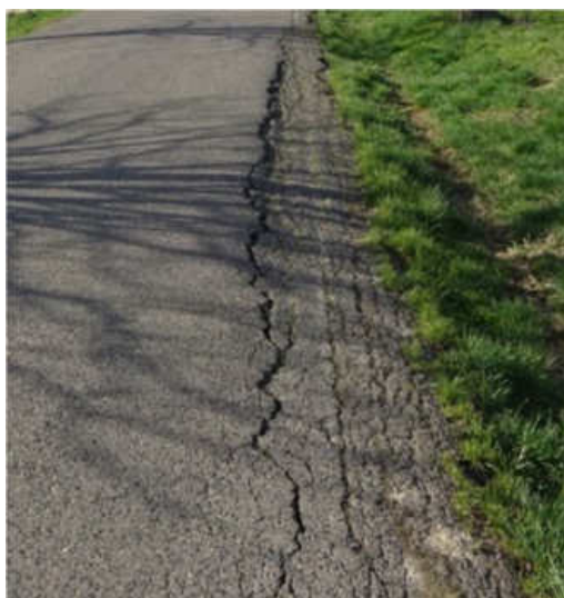
Obr. 40: Podélný zlom v ose budoucího jízdního pruhu;
