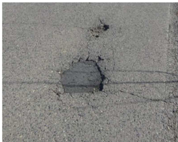
Obr. 34: Výtlučky v možné ideální stopě pro cyklisty;
