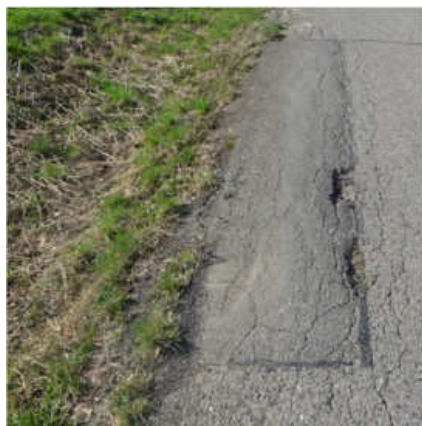
Obr. 46: Výtluk a pokles v potencionální jízdní stopě cyklisty;
