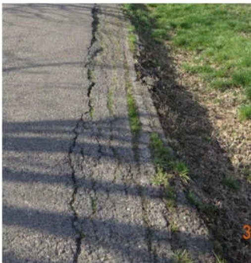
Obr. 38: Podélná prasklina okraje vozovky v ose budoucího pruhu pro cyklisty; Zborcený okraj silnice, příkrý příkop
