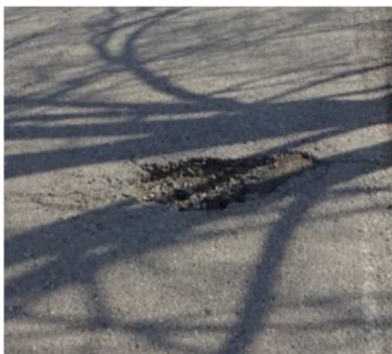
Obr. 32: Hluboký výtlupek ve vozovce v prostoru, který primárně využívají cyklisté;
