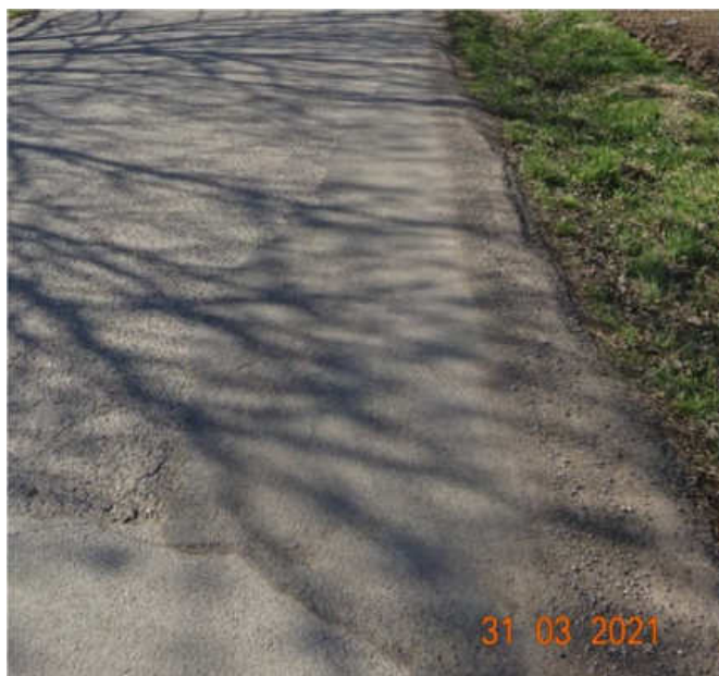
Obr. 25: Oprava kraje vozovky na NN 321
