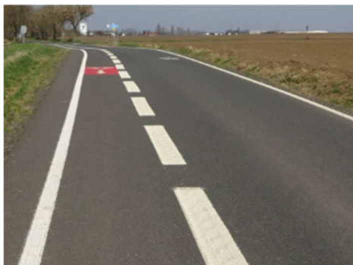
Obr. 13: Jízdní pruh pro cyklisty široký 1 metr odsazený od vozovky o 0,5 metru.
