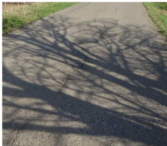
Velkoplošné poruchy vozovky v celé šíři
