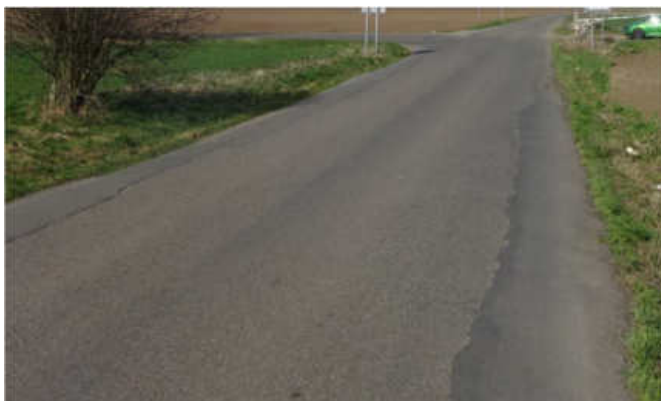
Obr. 23: Výsprava (obnovení) okrajů vozovky ulice Bystré
