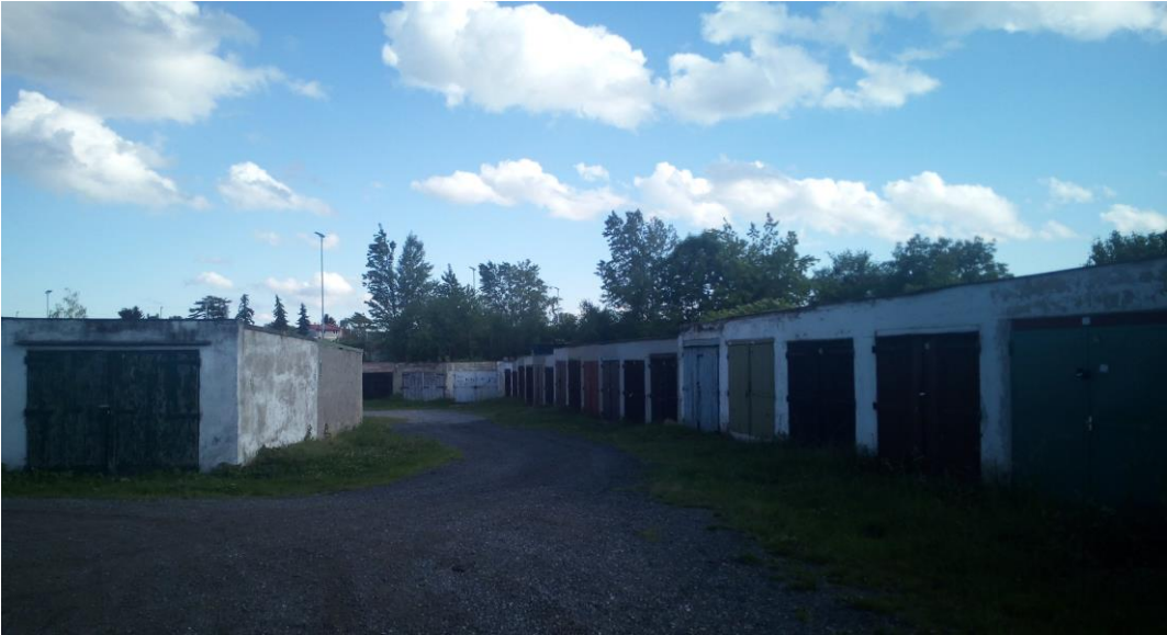
Garáže v ulici Železnobrodská.
